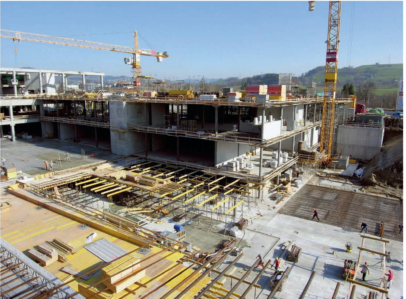
Stadion-Grossbaustelle in St. Gallen: Die AFG-Arena, benannt nach der Arbonia-Forster-Holding mit Sitz in Arbon, ist das erste Schweizer Stadion, das nach einem kommerziellen Unternehmen benannt wird. Es löst ab 2008 das Dauerprovisorium Espenmoos ab.
